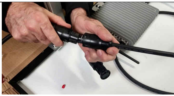
18. Conectando el cable AC al inversor
