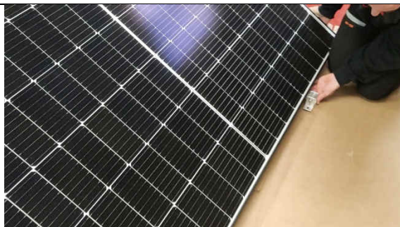
20. Levante cuidadosamente el panel para que se sujete sobre los soportes y ajústelos. Puede solicitar ayuda de otra persona si es necesario.
